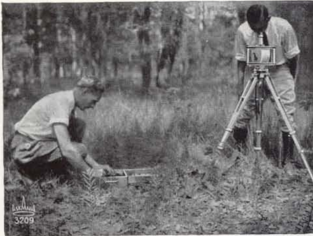
Fig. 12.-Determinación de la escala de una balanza magnética vertical
